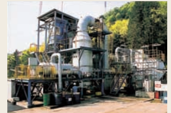
回収インフレーター作動処理設備
