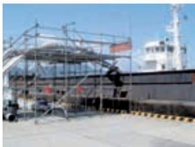
仮設された給水配管
